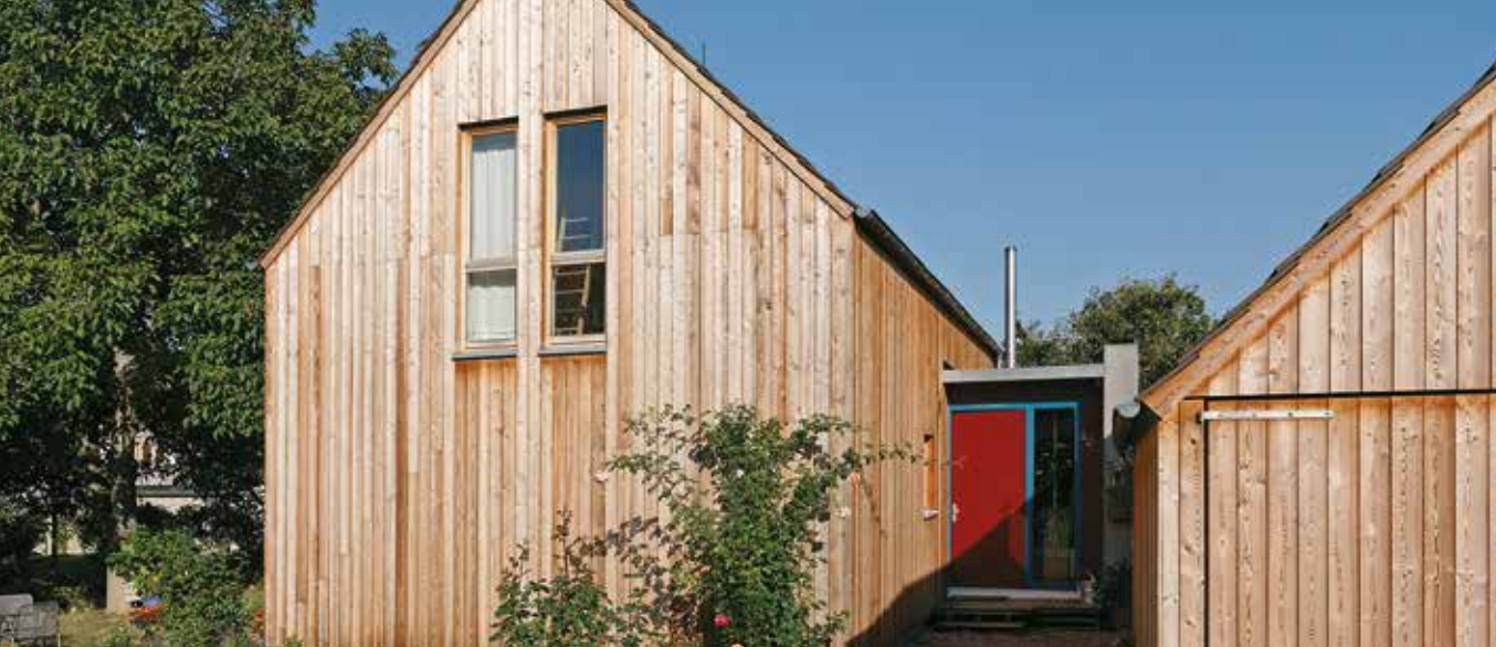
Moderne Fassadengestaltung mit Lärchenholz
