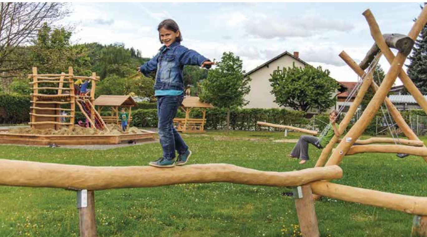
Robinie naturgewachsen, entsplintet und geschliffen
