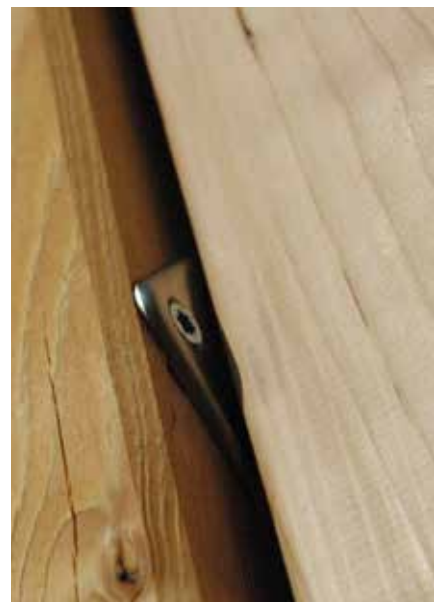
Vorbereitet für Befestigungssystem JodaFix®
