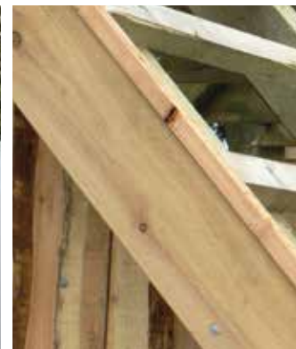
Lärchen – Dachstuhl im Detail
