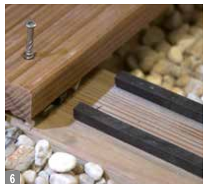
6 Praktisch: Selbstklebendes Ausgleichsband reguliert Unebenheiten.
