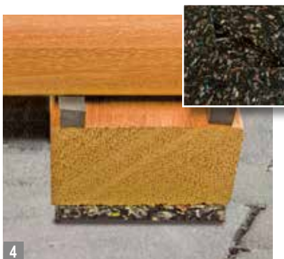
4 Gummi reguliert: Höhenausgleich-Pads für die Unterkonstruktion.
