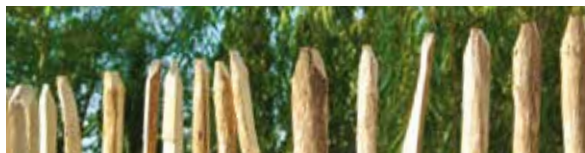
Handgespaltene Zaunstaketen mit Bast- und Rindenresten. Köpfe angespitzt
