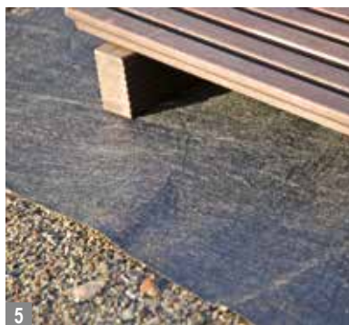
5 Wasserdurchlässiges Abdeckvlies gegen Durchwurzlung und Pfützenbildung.
