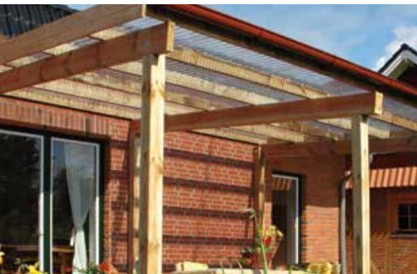
Terrassendach aus Lärchen-Leimholz
