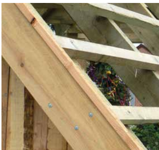
Lärchen – Dachstuhl im Detail
