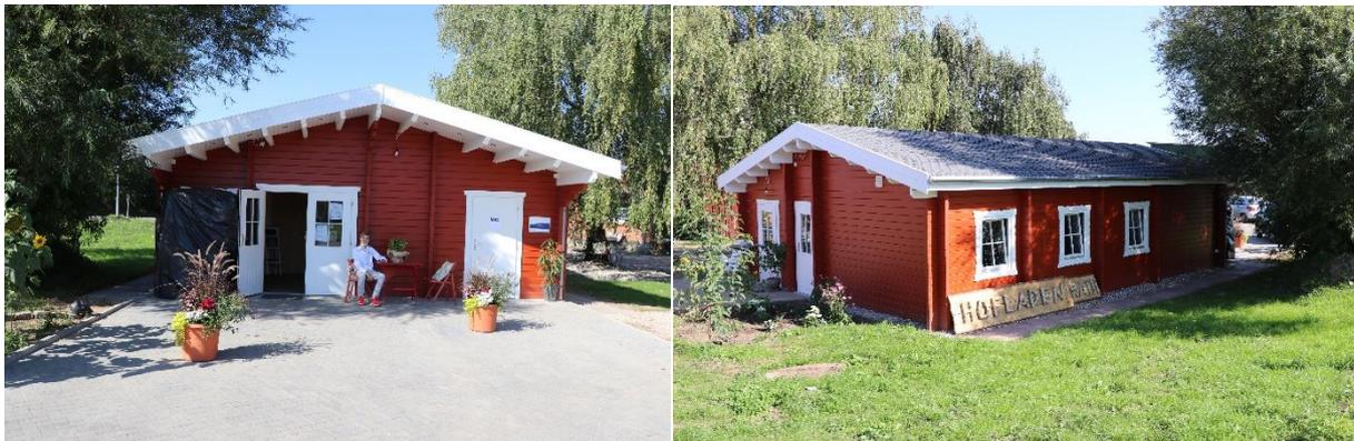
gänzten den Bau, dessen Wände komplett aus Blockbohlen, Nordische Fichte, naturbelassen mit einer durchgängigen Stärke von 70 mm bestehen. Er hat eine Länge von 10,00 m und eine Breite von 7,50 m, der umbaute Raum beträgt ca. 262 m<sup>3</sup>. Die nutzbare Fläche wurde mit Zwischenwänden in sechs Räume aufgeteilt, die unterschiedlichen Zwecken dienen. Der Farbanstrich außen wurde nach dem Aufbau aufgebracht.
